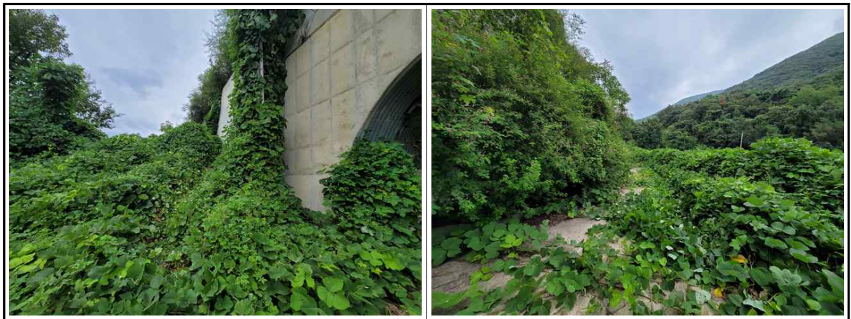
【사진 1.3.1】 지반, 기초부 전경
