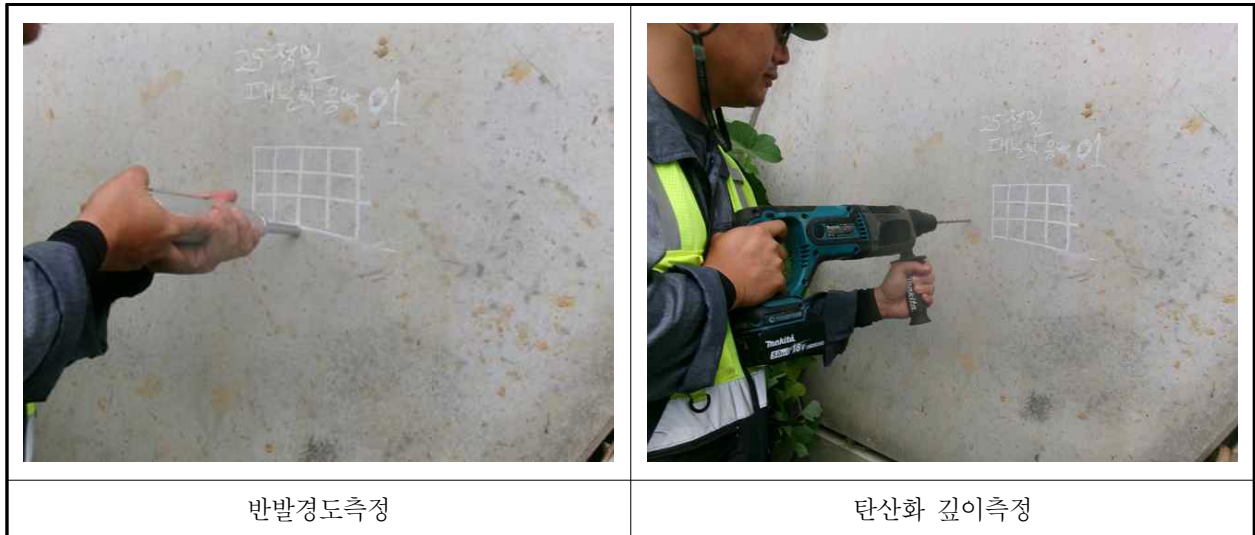
【사진 1.4.1】 재료시험 조사 전경
