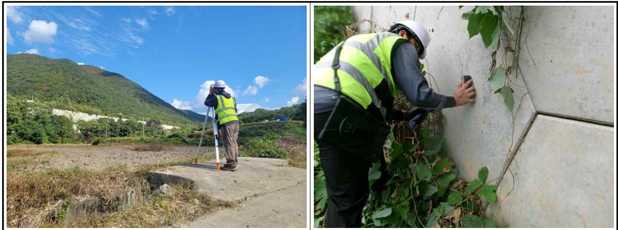
【사진 1.4.2】 측량작업 전경
